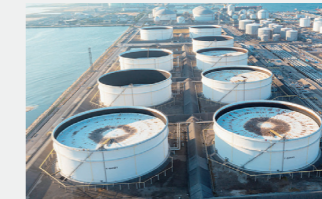
原油タンク及び大型LNGタンクでの洗浄パッケージ作業
