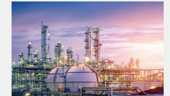
化学系プラント設備の定修に伴う気密検査
